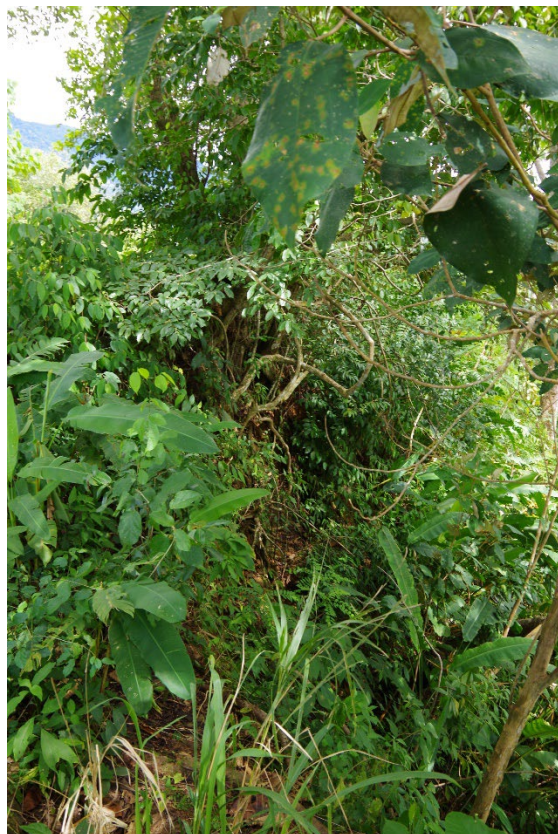
Grados máximos de desnivel y derrumbes
