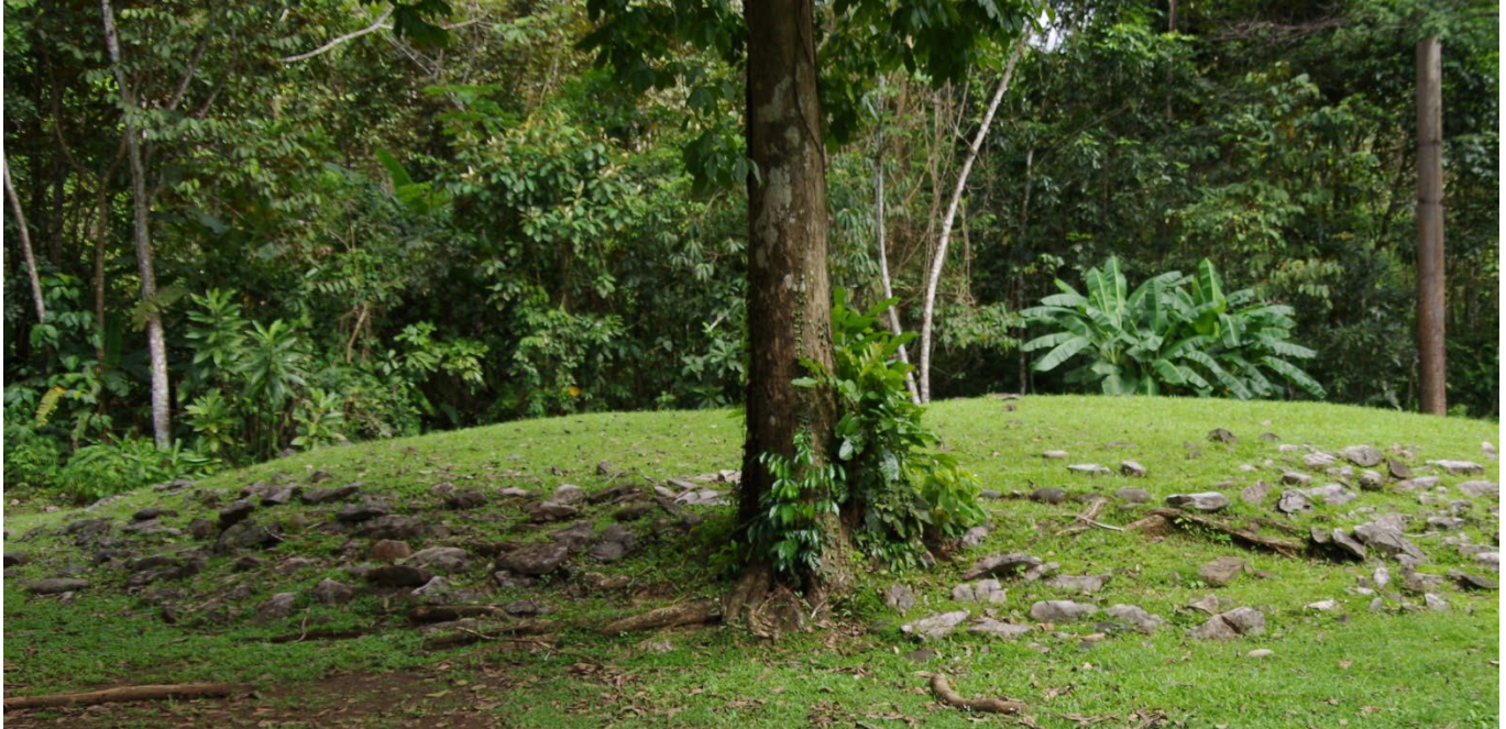
Daños ocasionados por árboles a montículos
