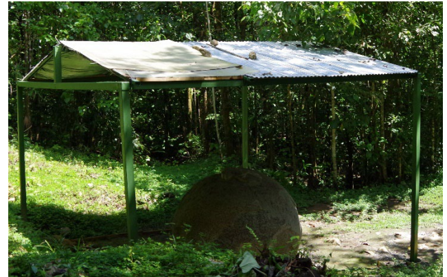
Año 2019 – Proceso de instalación de zinc
